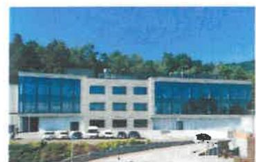
Nově vzniklý objekt s prefabrikovaným skeletem má odlišný typ designu oproti stávajícím objektům v areálu. Nový AO pavilon tvoří z velké části celoprosklený plášť s optickým členěním na tři celky. Nový AO pavilon je přistavěn a komunikačně propojen s Administrativní budovou SO13. Součástí naší dodávky byla na Administrativní budově nová střecha a také nová fasáda.
