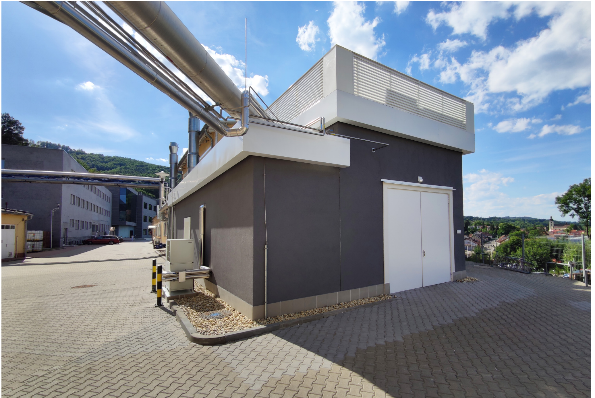
UNIT 2 – Spray Drying Oven Rooms | Synthon, s.r.o. | Blansko, Česká republika | 2022
